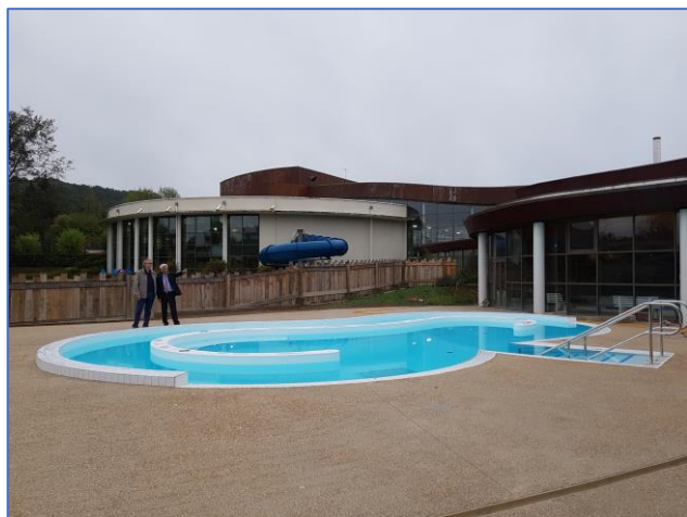
Aménagement bassin Espace Forme
